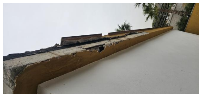
Frente de forjado en mal estado, se hace necesario su reparación.
