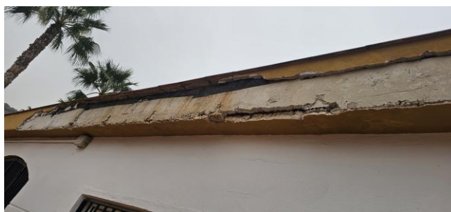
Frente de forjado en mal estado, se hace necesario su reparación.
