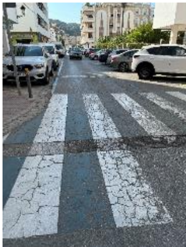
Firme fisurado
