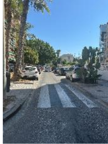
Pavimento disgregado, falta de mástic
