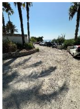
Socavones y blandones
