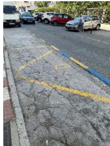
Aparcamiento fisurado
