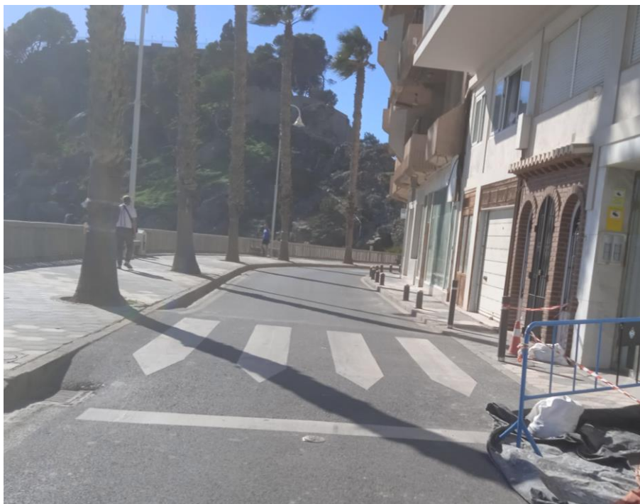
Foto 9. Pasos de peatones en Paseo Caletilla
