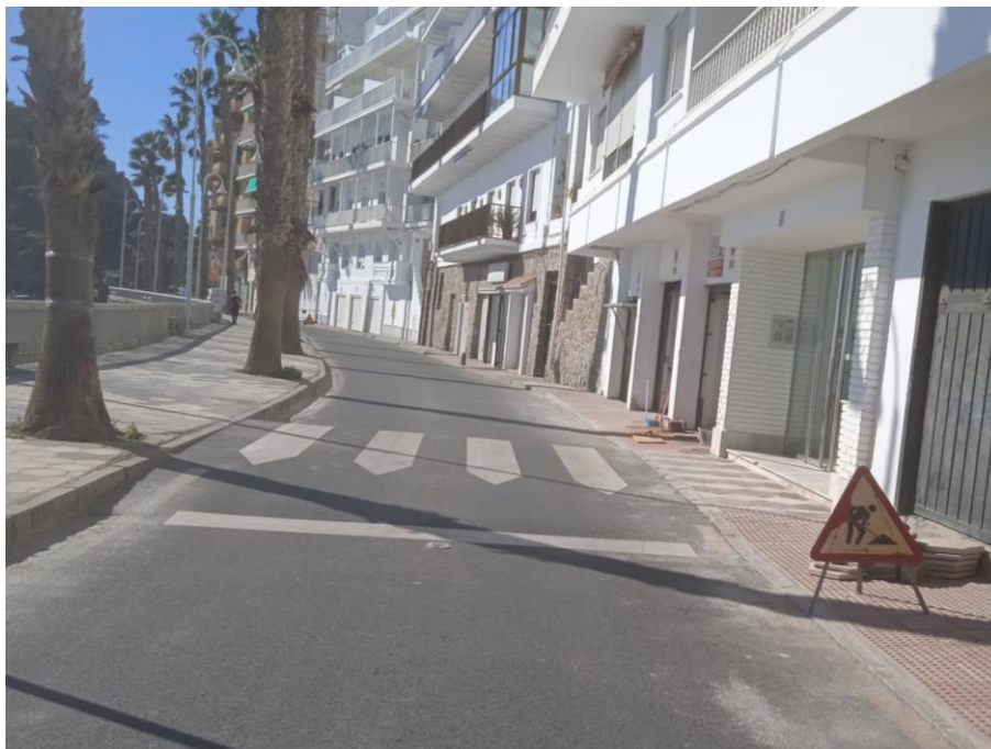
Foto 8. Pasos de peatones en Paseo Caletilla
