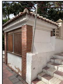
FACHADA LATERAL DCHA.
