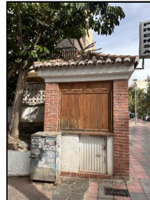
FACHADA LATERAL IZQ.
