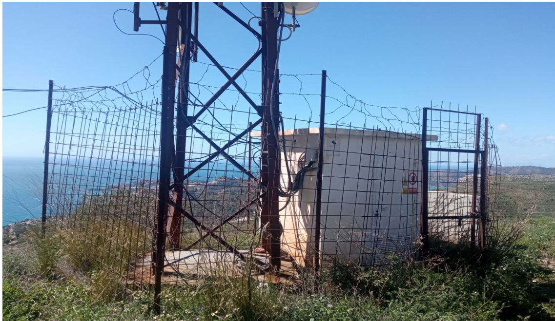
Caseta existente en la propiedad que se deber mantener:
