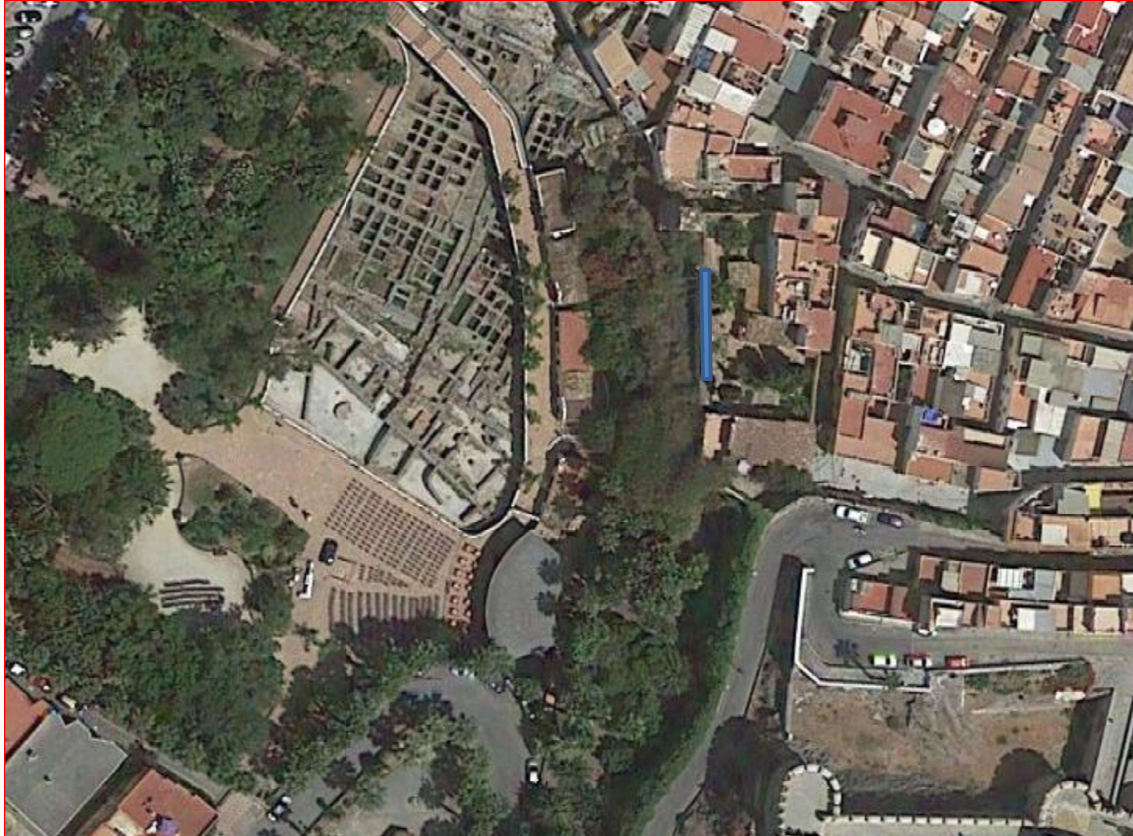
Zona prevista de intervención.
