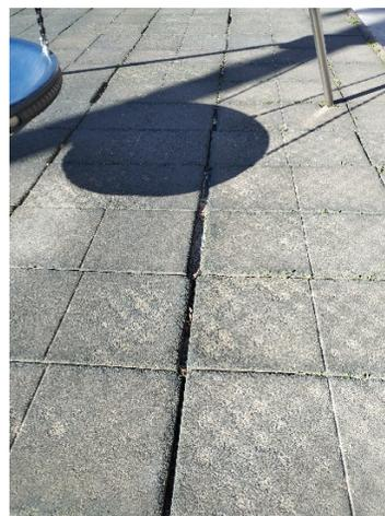
Podemos observar el mal estado del pavimento y el peligro que supone, además que por el paso del tiempo este pavimento elástico-flexible no reúne las propiedades y la capacidad de amortiguación exigida debido al cuarteamiento y endurecimiento de las mismas.
