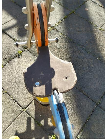
Podemos observar en la fotografía el mal estado del columpio plano, además el pórtico se encuentra debilitado y se recomienda cambiar el columpio en su conjunto.
