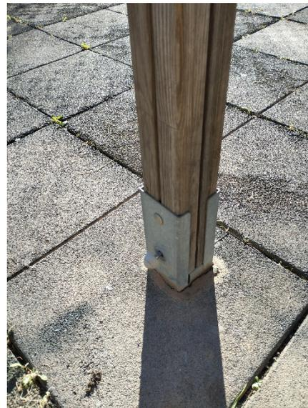
Aquí podemos observar el mal estado de la pintura y la falta de tornillería y tapones de seguridad.
