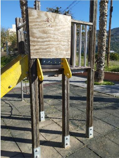
Este es el juego multifuncional, el cual le falta la rampa pasarela, tiene cuerdas en mal estado que hay que sustituir, tiene dos tableros en mal estado, necesita una puesta a punto general y pintura de todo el juego
