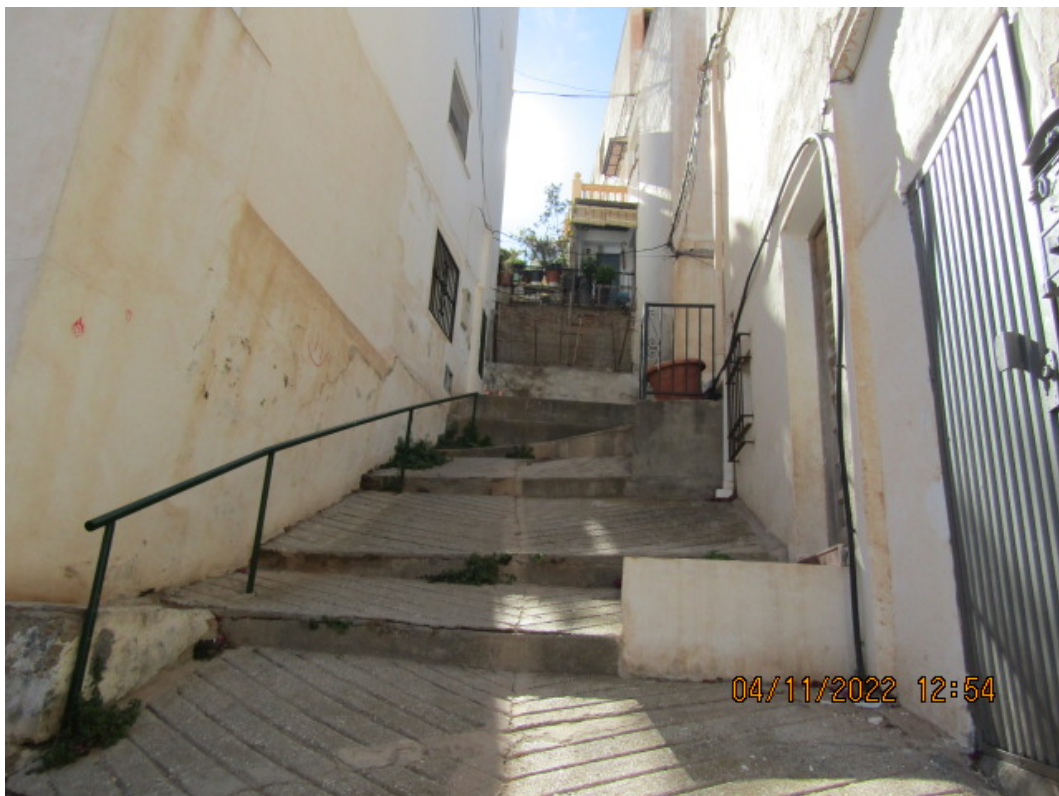
Foto 5. Detalle de rampas existentes y accesos a edificaciones
