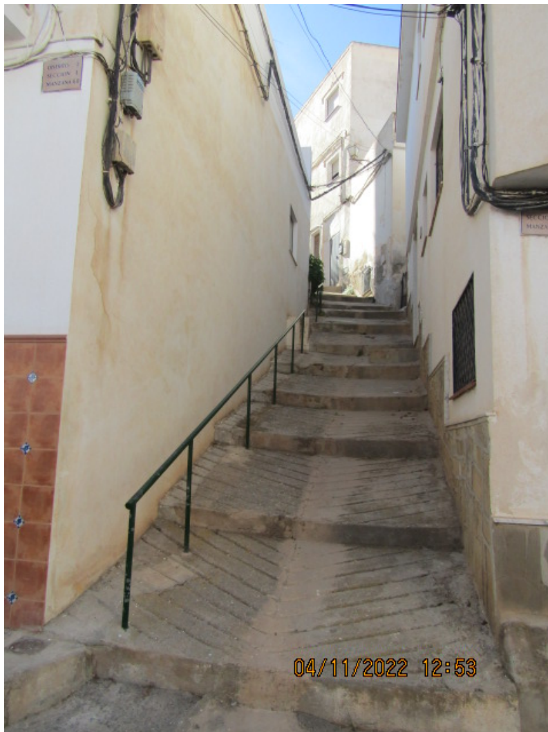
Foto 1. Vista general del tramo
