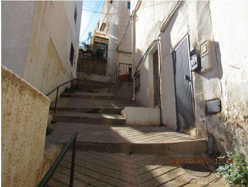
Foto 4. Detalle de rampas existentes y accesos a edificaciones
