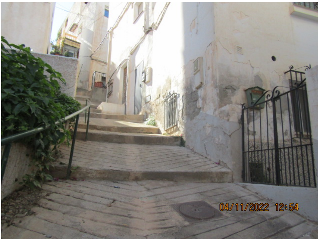
Foto 3. Detalle de rampas existentes
