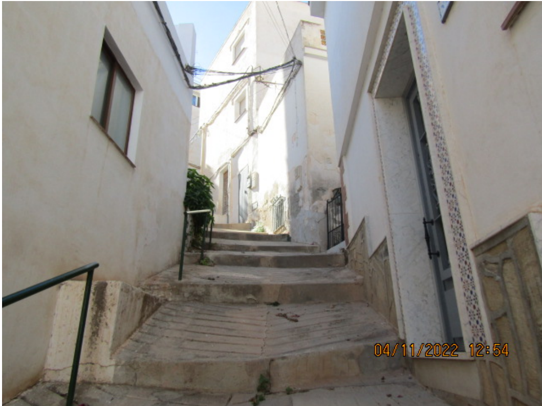
Foto 2. Detalle de rampas existentes
