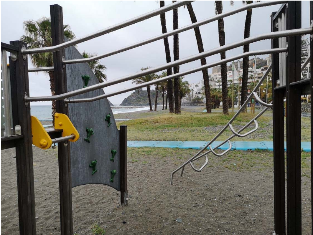
1. Instalación de pasarela de madera, incluyendo el apoyo que falta en un extremo
